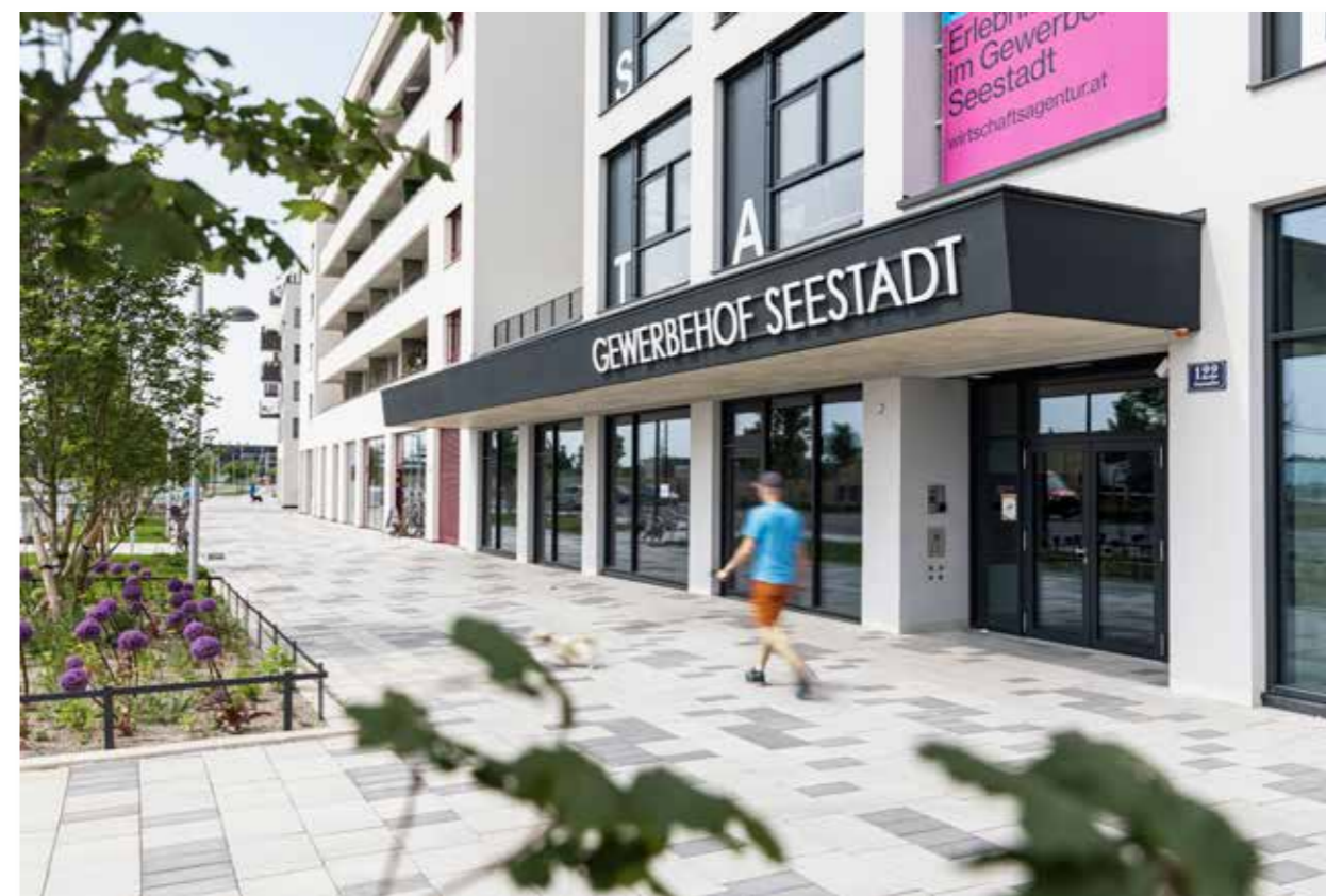
ANSICHT SEESTADT: DER GEWERBEHOF SEESTADT DER WIRTSCHAFTSAGENTUR WIEN BIETET VOR ALLEM PRODUZIERENDEN KMU UND INNOVATIVEN HANDWERKS BETRIEBEN DAS PERFEKTE UMFELD © LUIZA PUIU 2023
