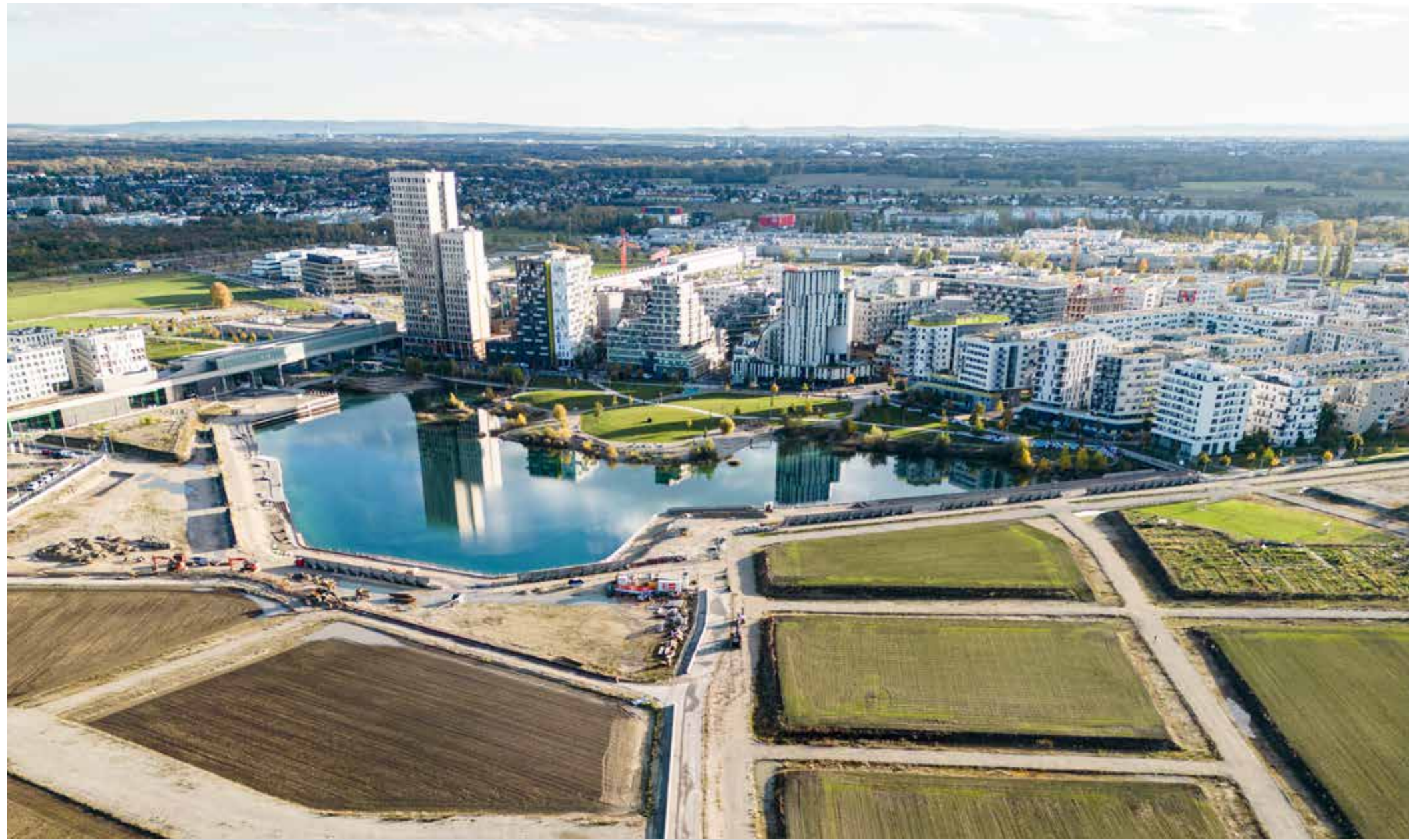
DROHNENANSICHT SEESTADT: DIE SKYLINE DER SÜDLICHEN SEESTADT UND DIE ERSTEN ARBEITEN AN DER WATERFRONT AM NORDUFER DES ASPERNER SEES © WIEN 3420 /2023
